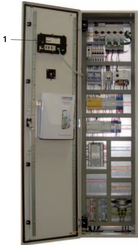
Schaltschrank Ölfeuerung Control cabinet oil firing
