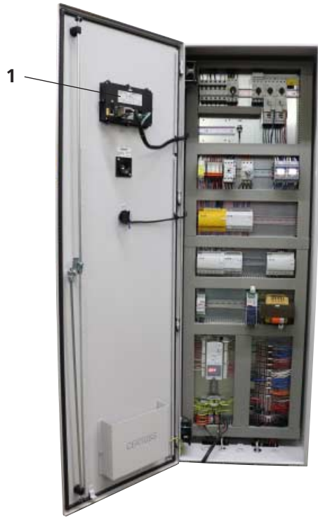
Schaltschrank Gasfeuerung Control cabinet gas firing
